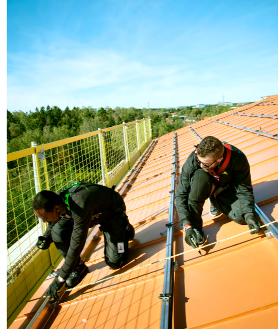
Bolus Yousef och Tsegay Rewani från Svea Solar monterar skenorna som solpanelerna ska fästas i.
