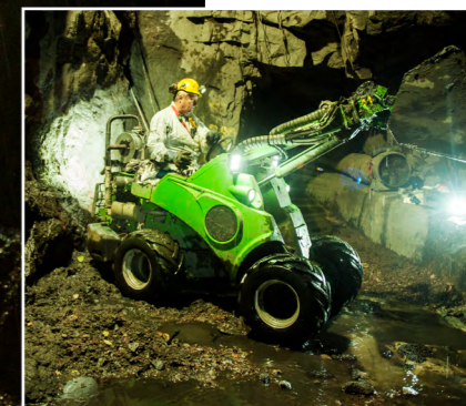
Med hjälp av traktorer töms tunneln skopa för skopa från allt det slam som har samlats under åren.
